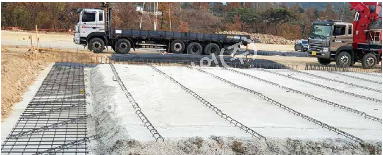
XY철근격자망 하차 및 스페이서(H 80) 설치
