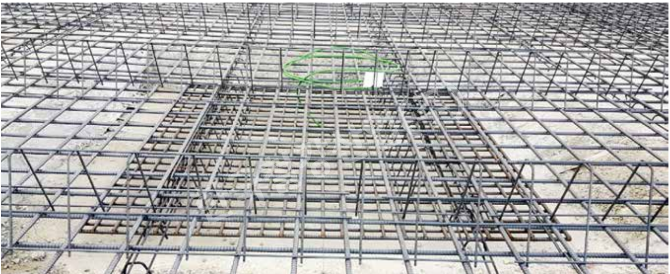
A형 제어바 설치
