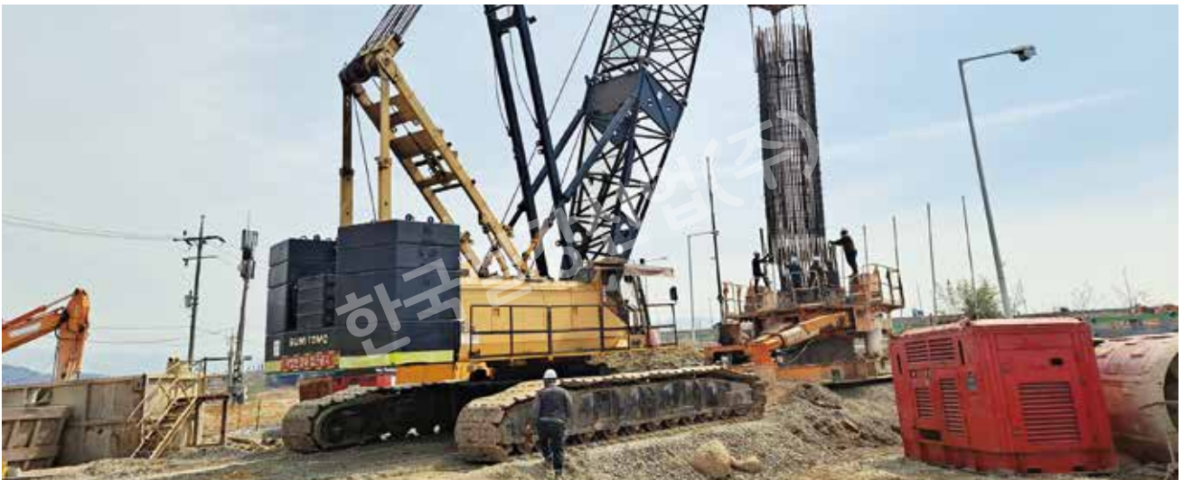
Ø2,500 RCD用 원형케이지 직립양중 및 연결 작업
