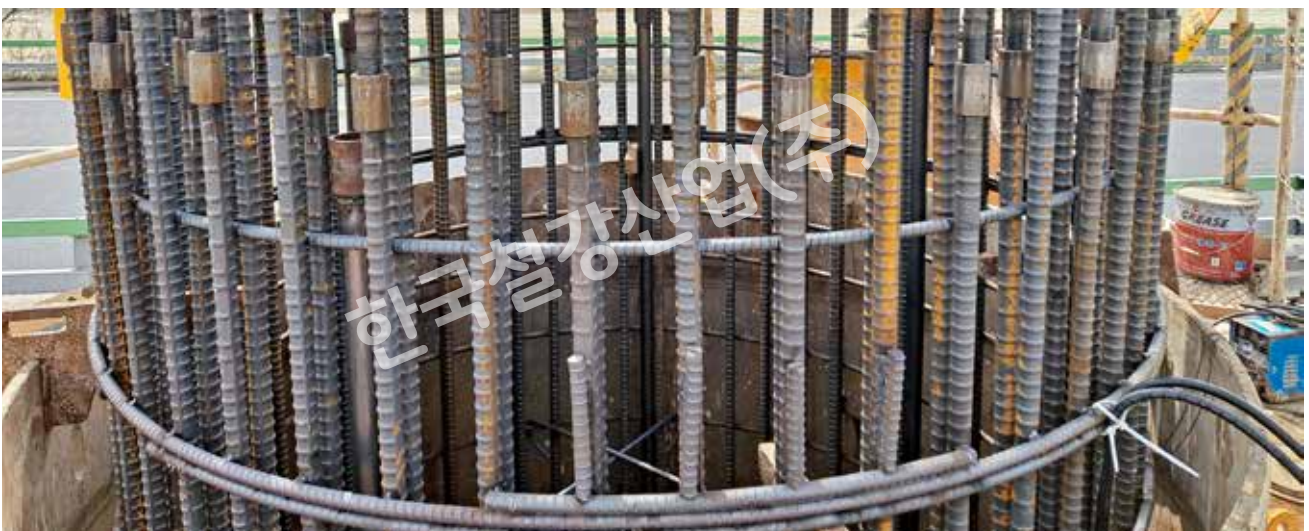
Ø2,500 RCD用 원형케이지 커플러 체결 및 근입
