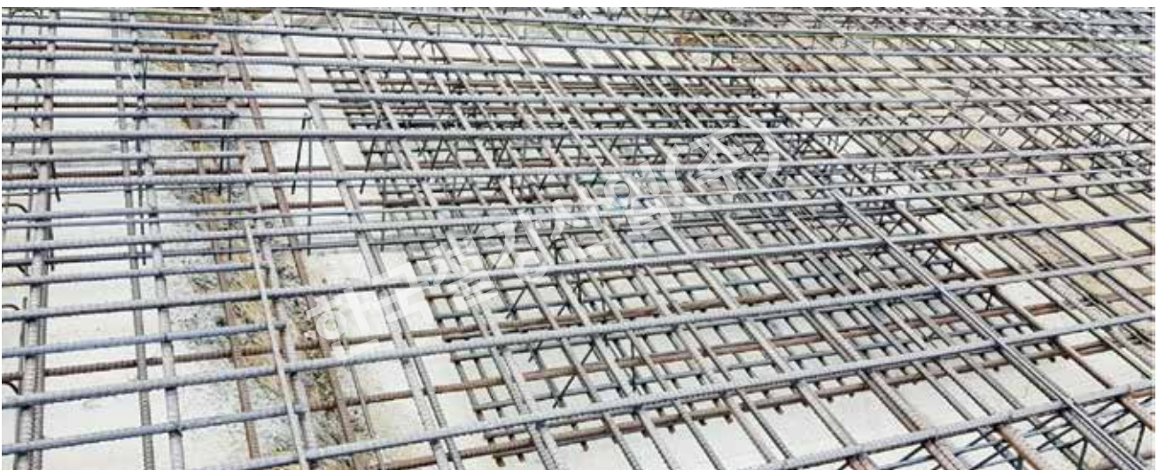
XY철근격자망 상부근 가로방향 설치
