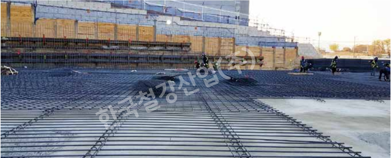
XY철근격자망 하부근 세로방향 설치
