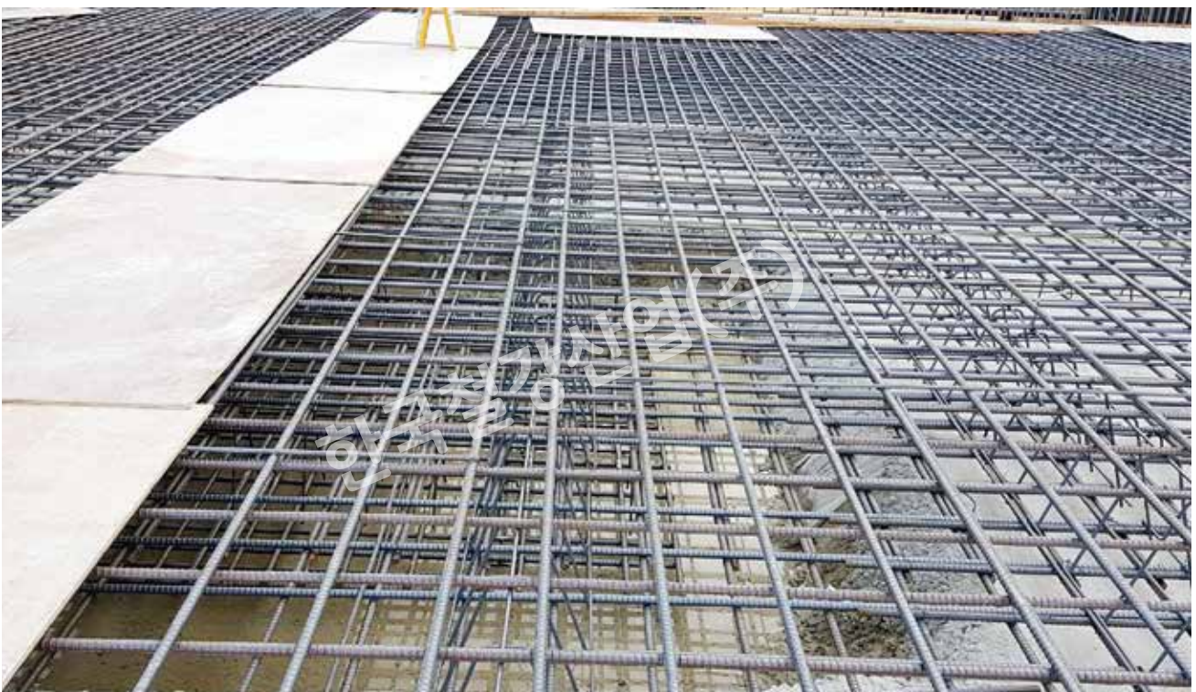
상부 보강 철근 배근
