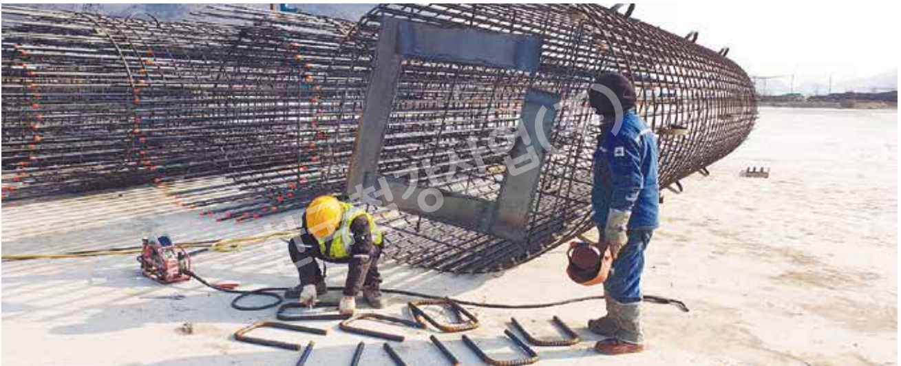
Ø3,000 RCD用 원형케이지 떠오름방지판 및 체어바 용접
