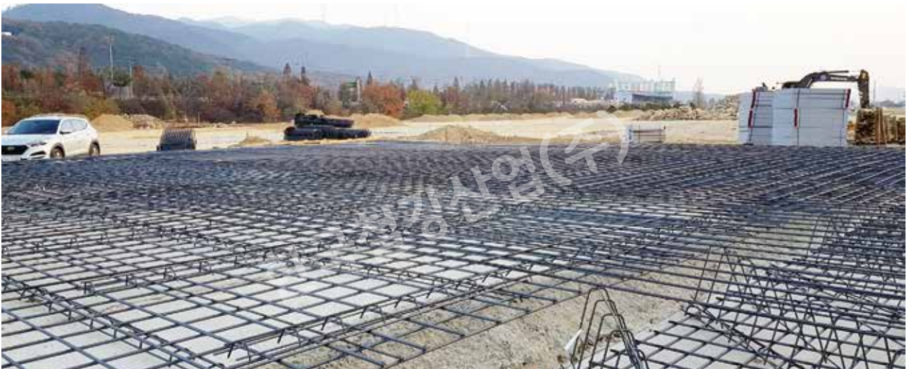
XY철근격자망(슬라브) 상부근 설치
