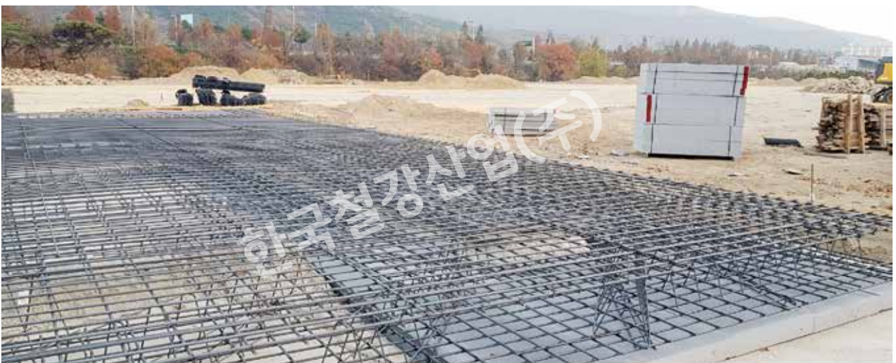
Full철근격자망(줄기초) 상부근 설치
