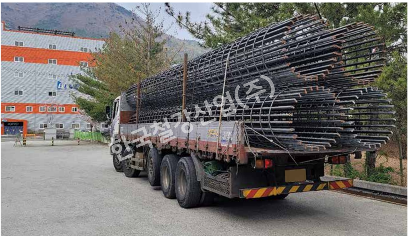
원형케이지 출하 – 창원 동원로엑스II 신축공사 <동원건설산업(주)>
