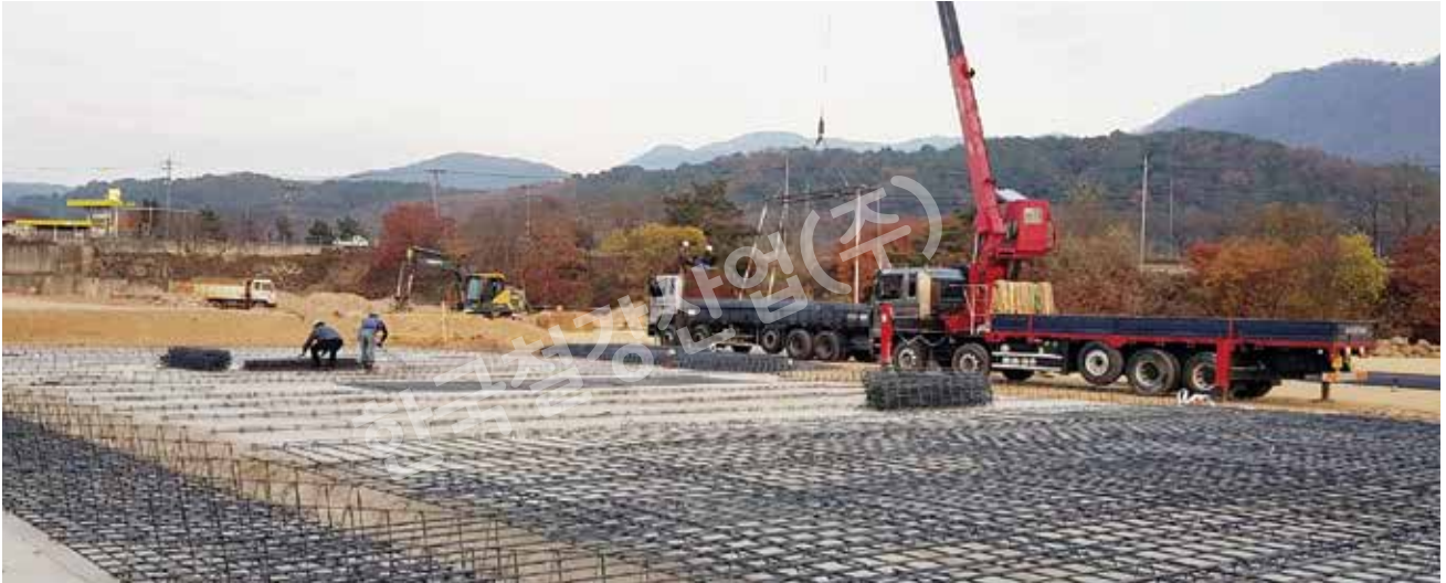
XY철근격자망(슬라브) 세로방향 설치
