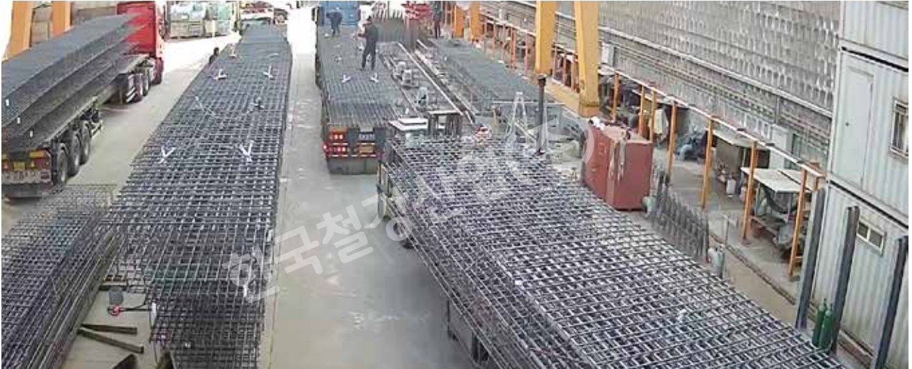
슬러리월 상자 - 부산북항 재개발사업 지하차도 <쌍용건설(주)/(주)금호지질>
