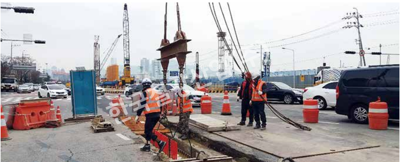
철근망 근입 완료
