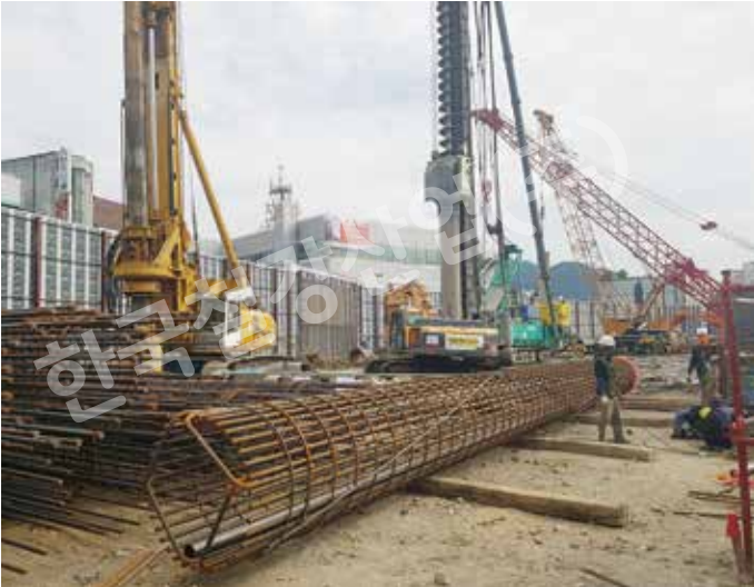
RCD用 원형케이지 체어바 용접
