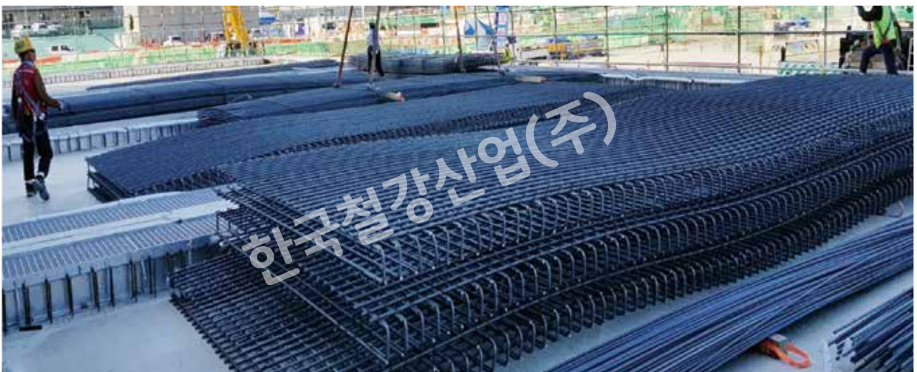
Full철근격자망(슬라브用) 현장 납품 - 삼성전자 평택공장 P2 Project <삼성엔지니어링(주)>
