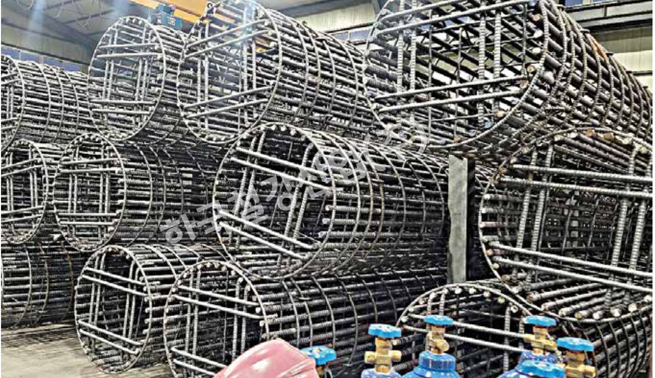
원형케이지 야적(PRD 철근망) – 창원 멀티컴플렉스 신축공사 <현대엔지니어링(주)>
