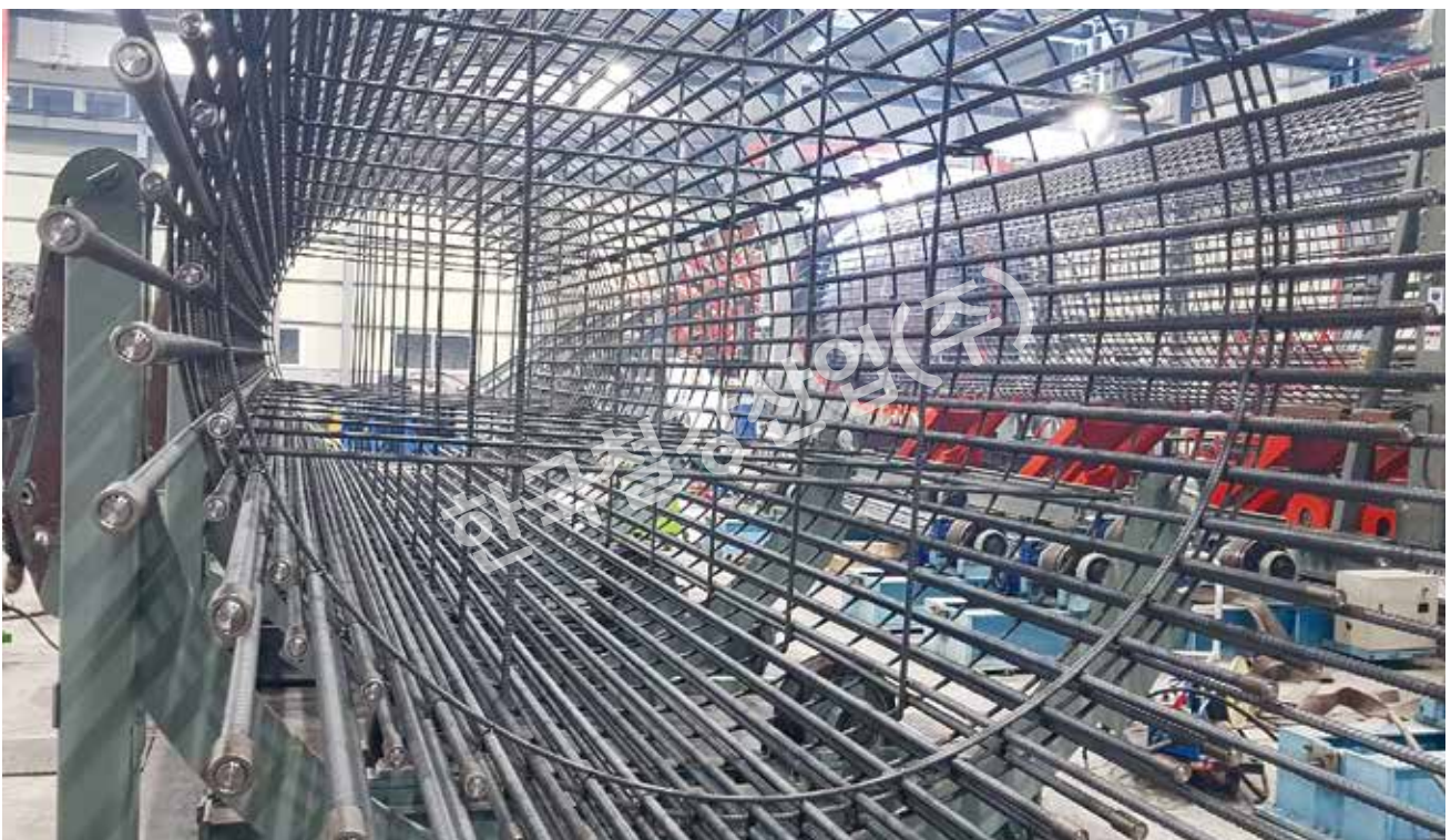
주근 2단 RCD - 매리-양산 낙동대교 건설공사 <(주)KR산업 / 태삼건설(주)>
