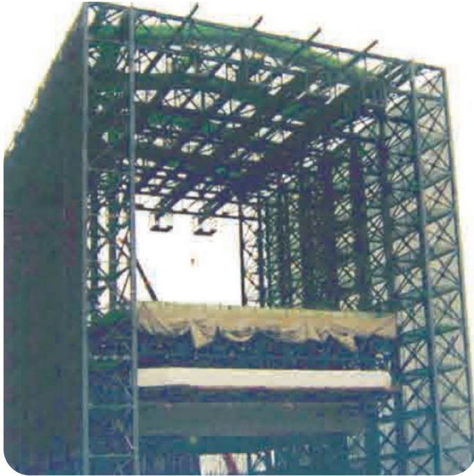
· 케이스 구조물 벽체 2단 조립
