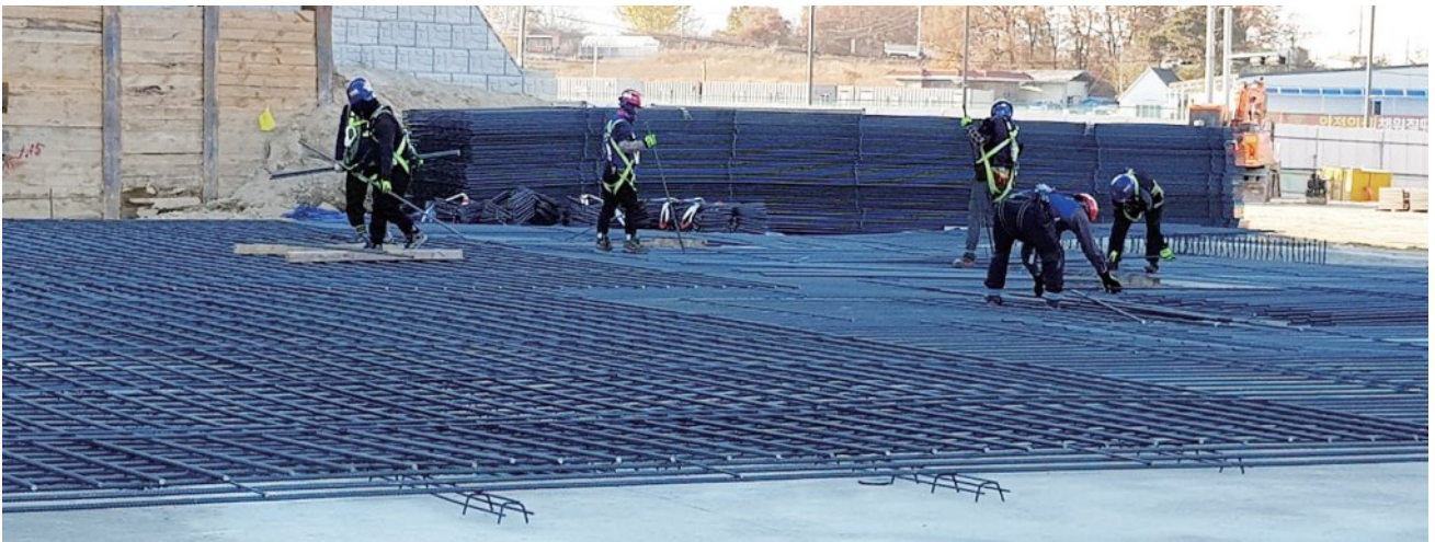
XY철근격자망 하부근 가로방향 설치
